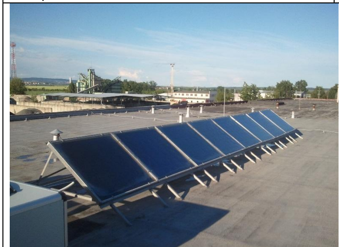
Realizace solárních poduškových kolektorů v AQUAdemu
